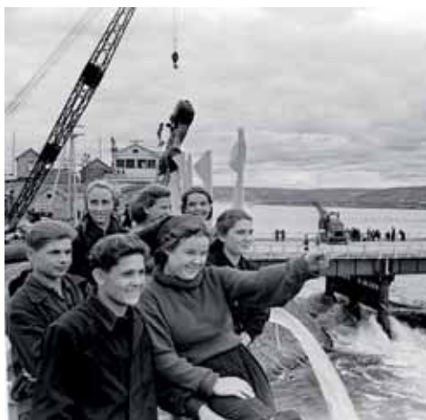
Возведение Братской ГЭС
