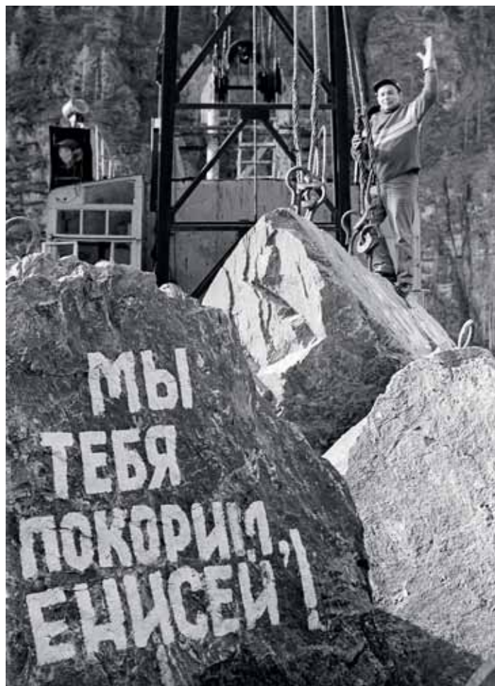
Саяно-Шушенская ГЭС, 1975 год. Строители готовятся к перекрытию Енисея
