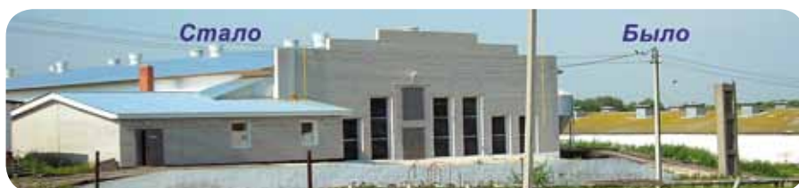
Фото 2. Идет реконструкция птицефабрика «Комсомольская» в Челябинской области
