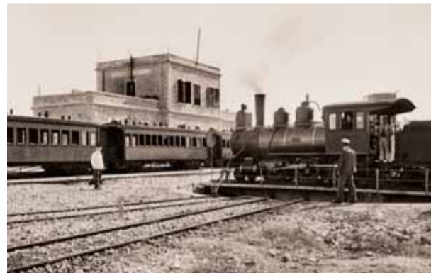
Устройство для разворота паровозов на иерусалимском вокзале, 1900 год
