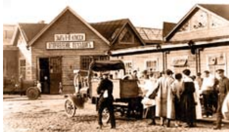
Временное здание Казанского вокзала, 1915 год
